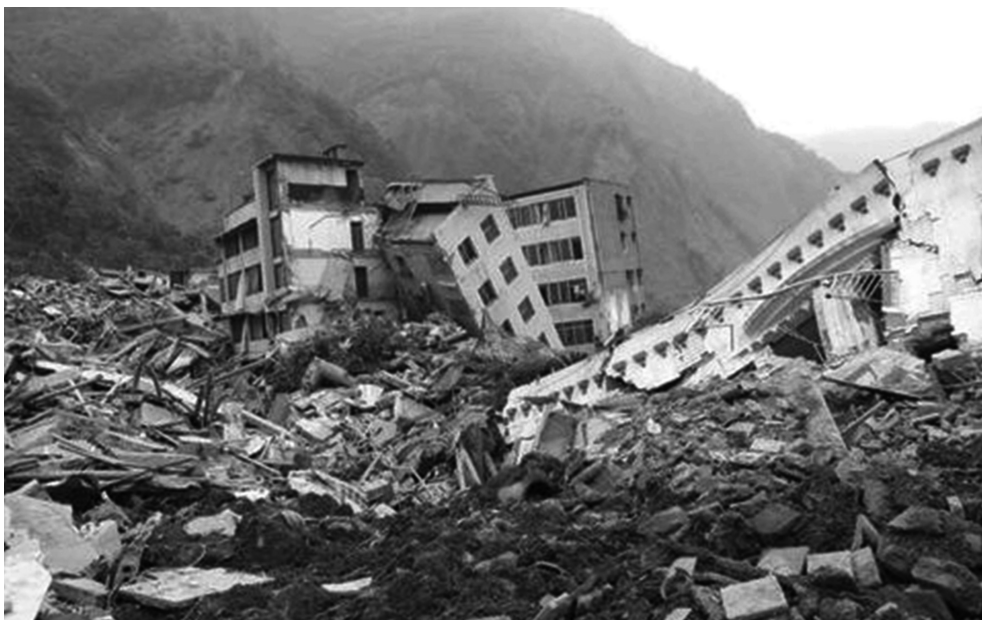
写真1 汶川大地震直後の様子
